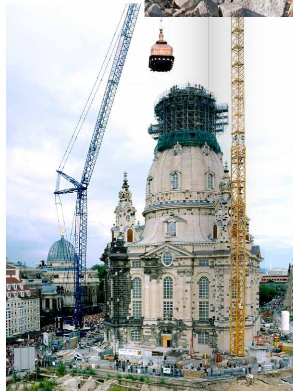
Im Rahmen einer gottesdienstlichen Feier wurden am 22. Juni 2004 Turmhaube und Kreuz mit einem Spezialkran aufgesetzt.
